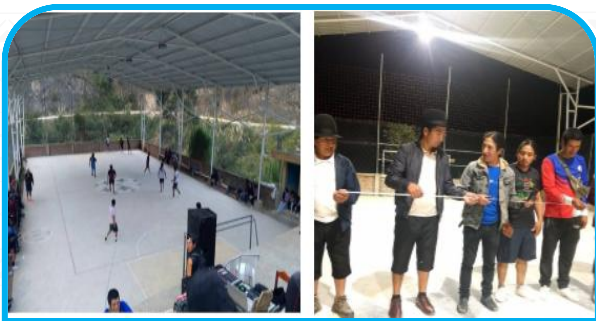
Imagen 03. Reconstrucción de piso de la cancha de Censo
